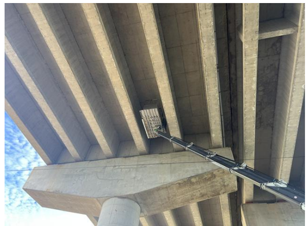
고소차를 이용한 근접조사
